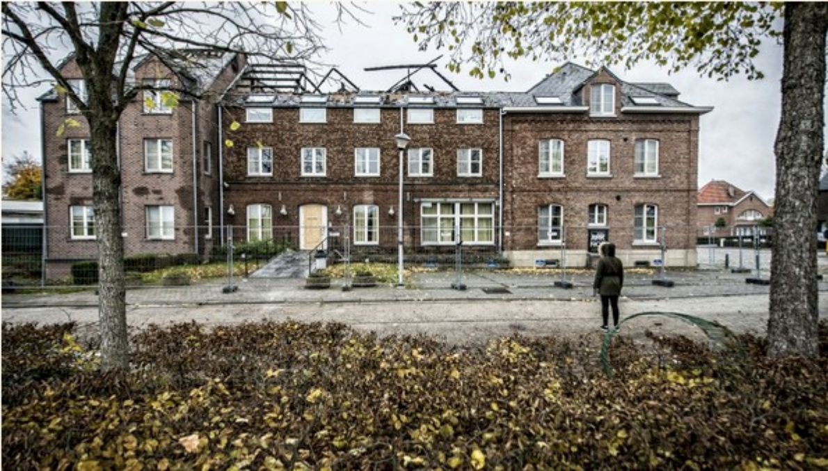
Het door brand geteisterde gebouw
